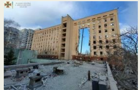
露軍のミサイル攻撃により破壊されたニコライウ州庁舎（2022年4月）【ウクライナ緊急事態庁ニコライウ州本部】
