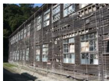
老朽化した施設 1942年建設 (築80年)
