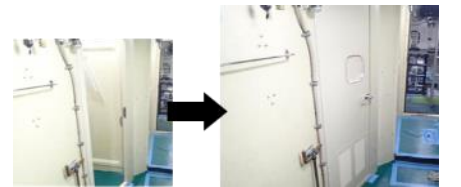
女性用区画の整備 (艦艇におけるシャワー室前通路扉の設置)
