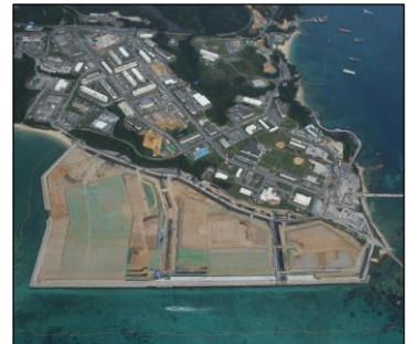
普天間飛行場代替施設の建設
