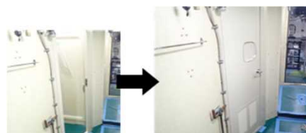
女性用区画の整備 (艦艇におけるシャワー室前通路扉の設置)
