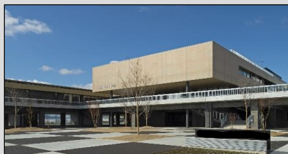
学校の防音工事（伊勢市）
