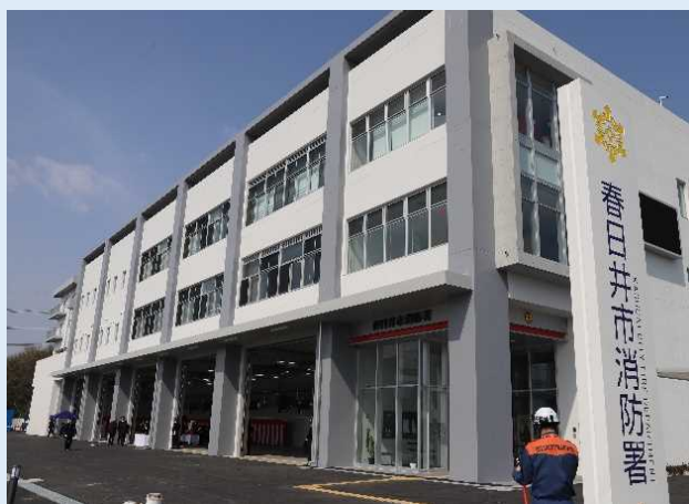
【消防署新庁舎】
