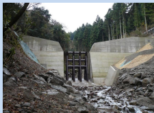
砂防施設整備 (白山分屯基地)
