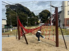
公園整備 (小牧基地)
