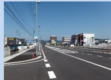
道路整備 (岐阜飛行場)
