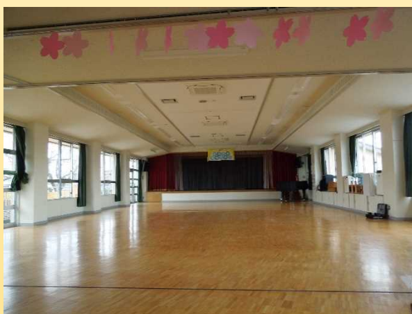
遊戯室（空調設備機能復旧工事後）
