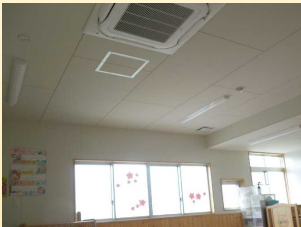
乳児室（空調設備機能復旧工事後）
