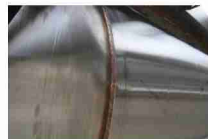
水タンクの溶接後
