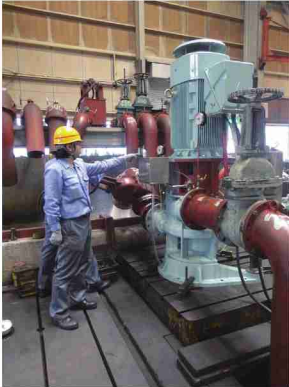
ポンプの試運転検査の様子
