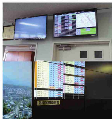
署所情報表示盤(上)と車両運用表示盤(下)
