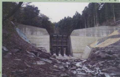
大原川砂防工（三重県）
