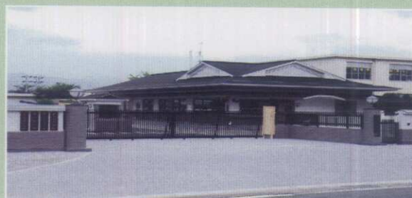
豊川駐屯地 警衛所 平成20年8月完成
