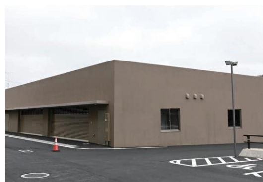
令和8年2月に完成した防災備蓄倉庫
