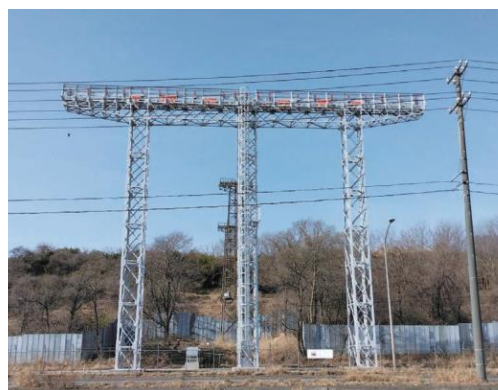
鉄塔新設②
