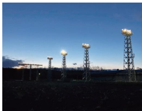
鉄塔新設①
