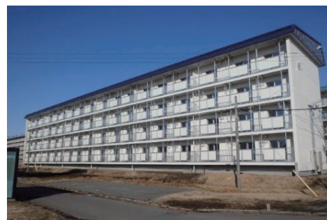
全面改修を実施した宿舎
