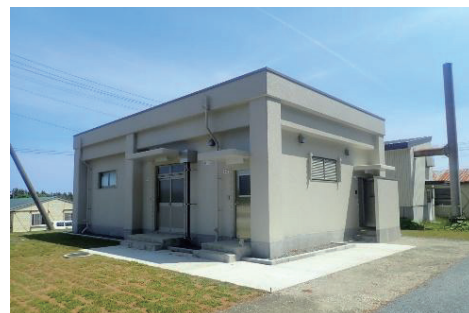
新設した浴場の外観
