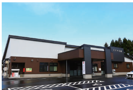
完成した「そでやま館」の全景
