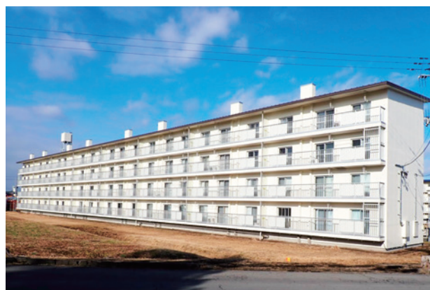
改修工事後の宿舎の外観
