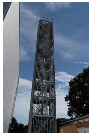
白河工場にある30m試験タワー。大型船のタンク高さと同等のサイズで、実液による実証試験ができる。
