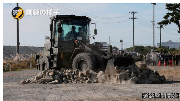
陸自重機による道路啓開
