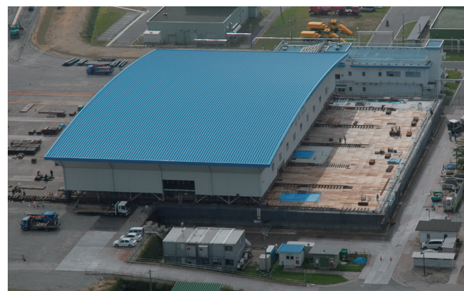
基礎を約3.5mの高さまで嵩上げし（右側）、曳家工事中
