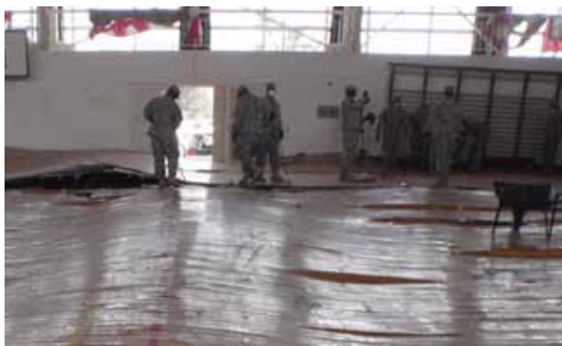
汚泥の除去と床のクリーニング
