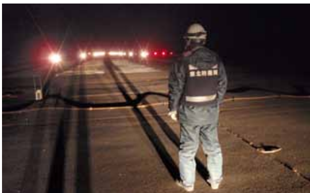
航空灯火施設の応急復旧作業 （夕方から夜通し実施）
