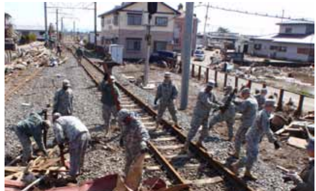
陸前小野駅での瓦礫の撤去作業
