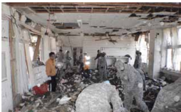
瓦礫等の撤去作業状況
