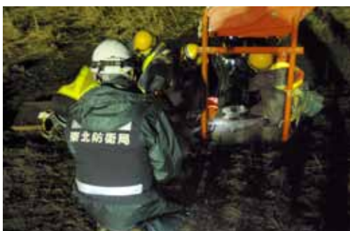
灯火機器設置工事の様子
