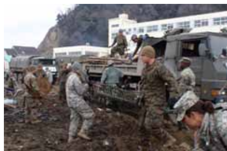
△ 石巻市での瓦礫除去
