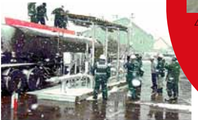
△ 松島基地 燃料施設復旧
