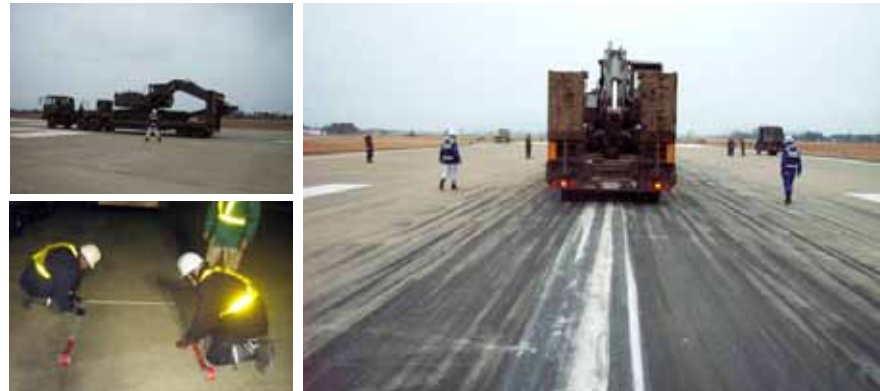
△ 松島基地 舗装調査
