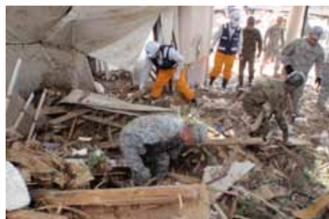
△ 東松島市野蒜駅での瓦礫除去
