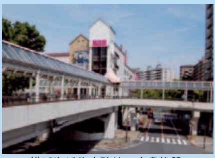
横浜海浜住宅跡地の商業施設
