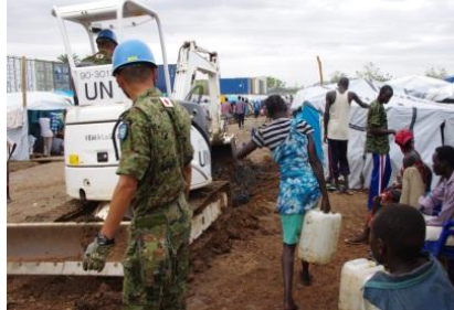
避難民保護区域の排水溝整備を実施する隊員(南スーダン)
