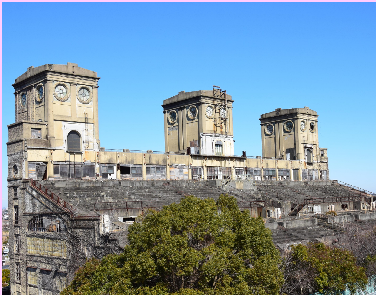
根岸住宅地区から見た旧根岸競馬場一等馬見所
