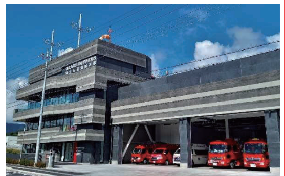
新消防庁舎の外観
