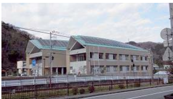
太陽光発電システムの設置
