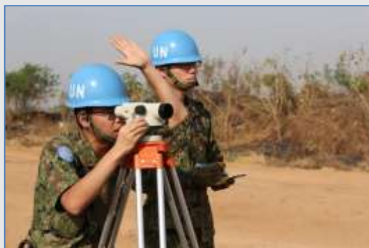
ジュバイエイ間 基幹道路補修 (測量)
