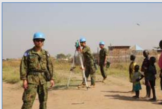
ジュバ市ナバリ地区 コミュニティ道路整備 (警備)
