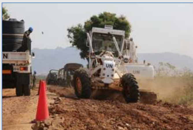
ジュバイエイ間 基幹道路補修
