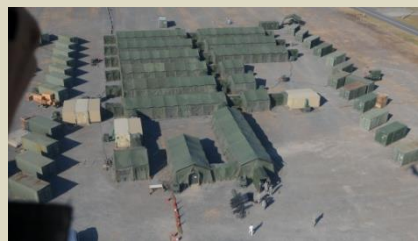
テント、コンテナにより展開された野戦病院
