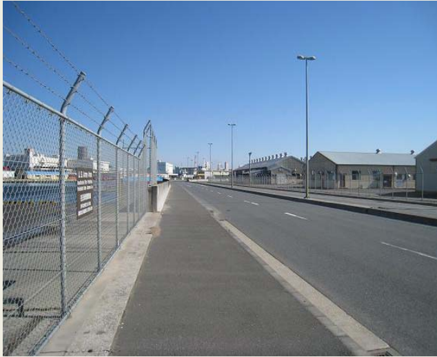
港湾施設(道路)
