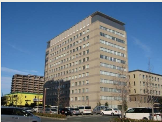
新庁舎の全景
