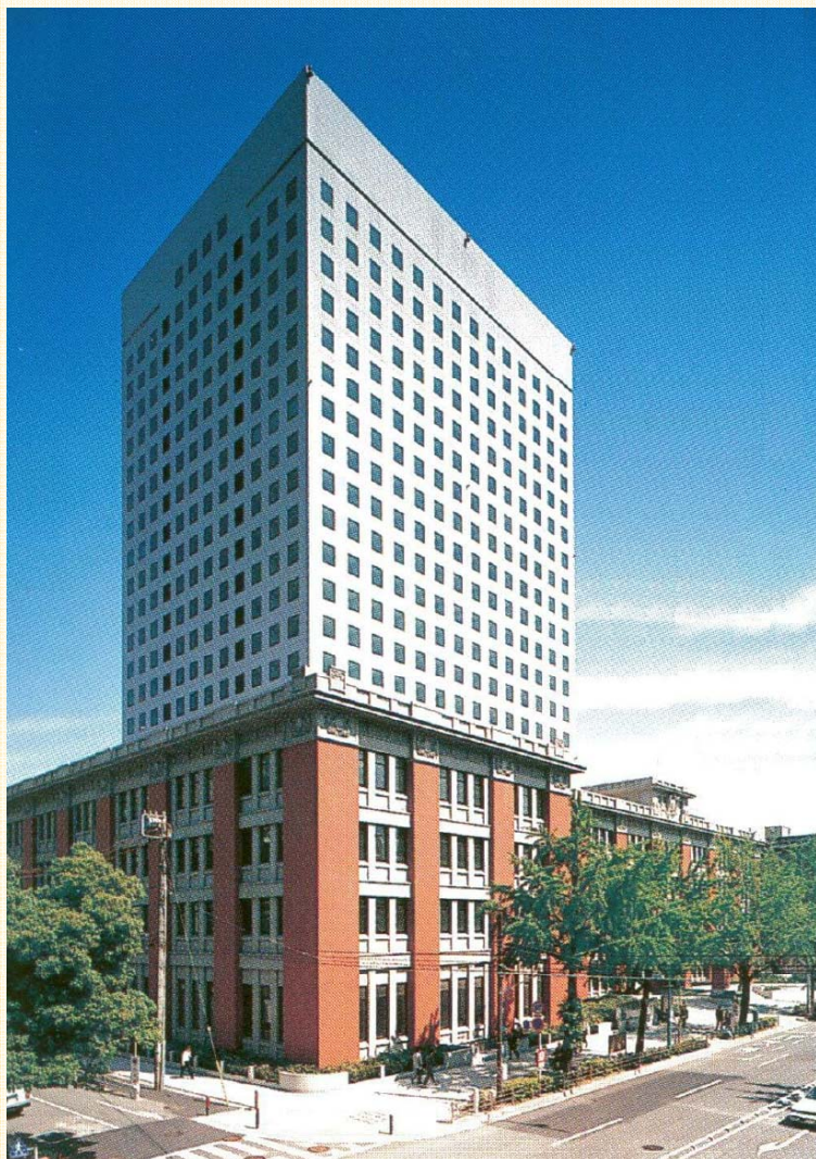
横浜第2合同庁舎 (南関東防衛局本局)
