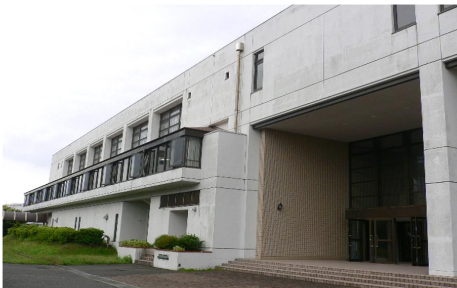
【参考】防衛大学校・体育館空調改修等(イメージ)
