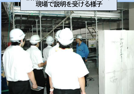
防衛大学校内で、建設工事中の現場で説明を受ける様子
