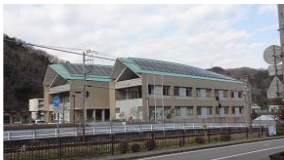
太陽光発電システムの設置
