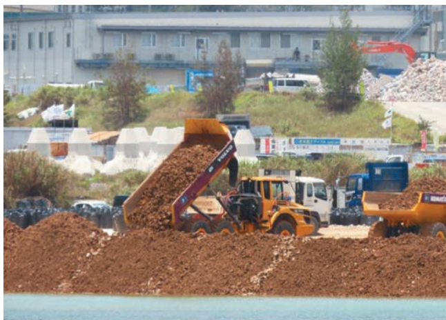
埋立区域③－4 埋立工事の様子
