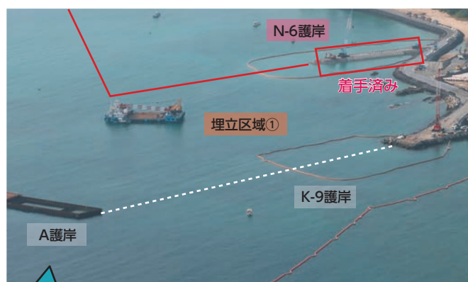
N-6護岸の工事の様子
