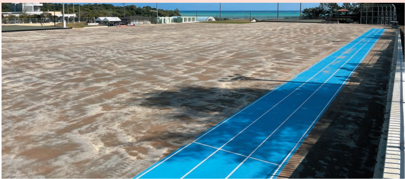
完成した久志屋外運動場
