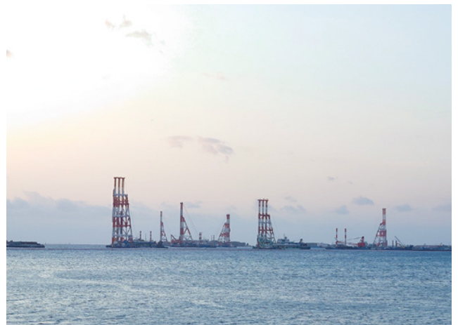
地盤改良船6隻の停泊状況
