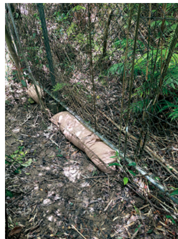
補修後の状況
