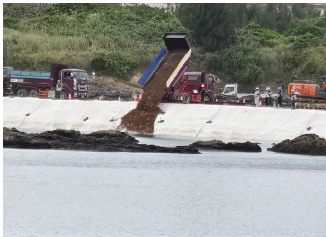
埋立区域③-3埋立工事着手の状況 (令和7年11月28日撮影)
