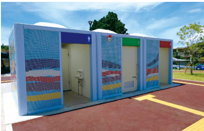
多目的トイレ
