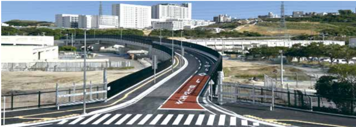
完成した宜野湾市道喜友名23号(国道側から)
