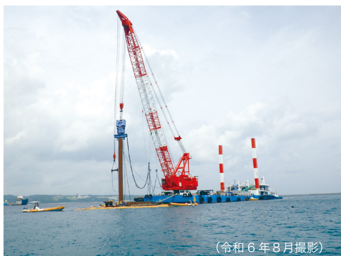
A護岸工事状況
