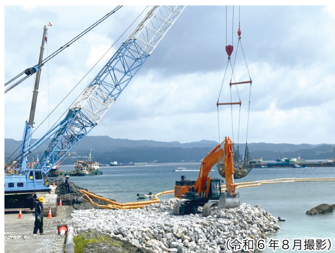
N-1護岸工事状況
