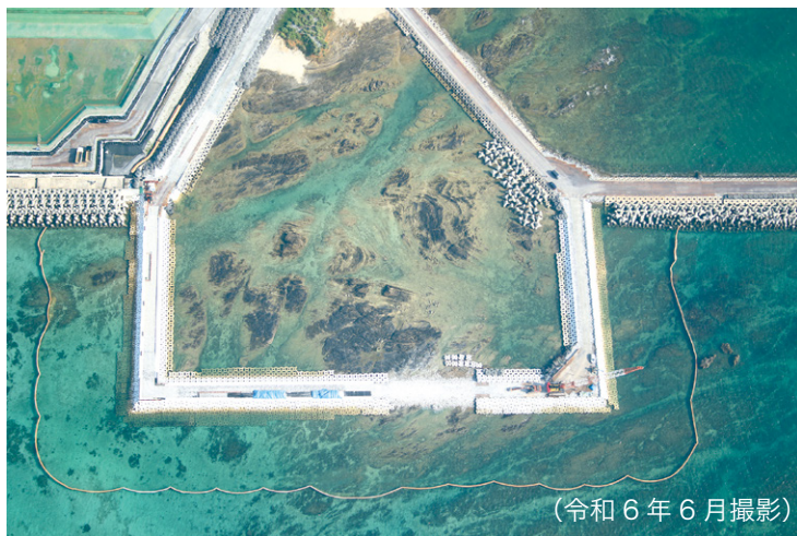
埋立区域③-1 施工状況
