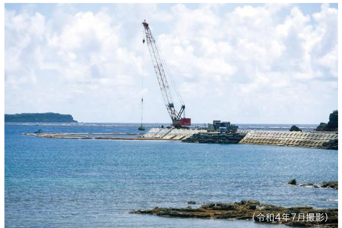
K-8護岸延伸工事
