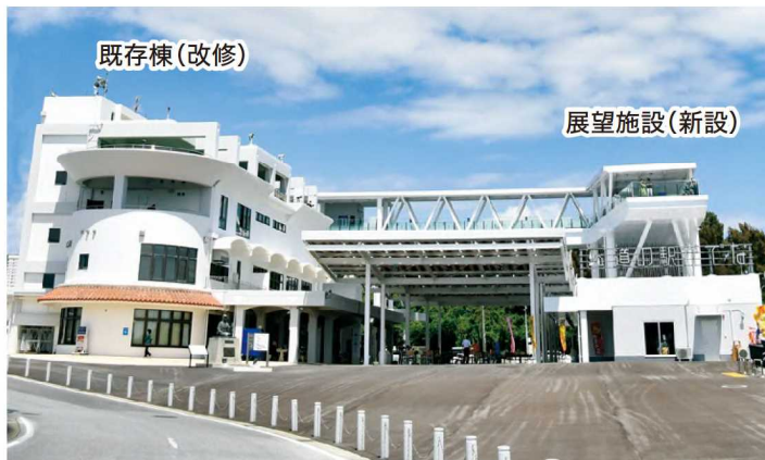
道の駅かでな外観
