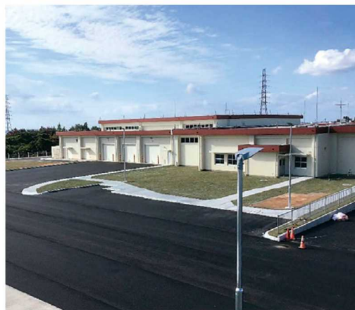
給食センター外観
