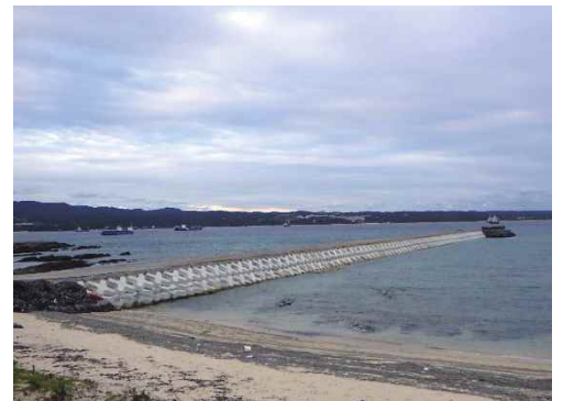
(令和3年11月撮影) N-2護岸 設置完了
