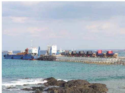
(令和3年12月撮影) N-2護岸 揚土作業状況
