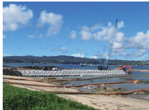
(令和3年9月撮影) N-2護岸 施工状況
