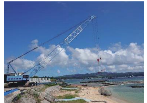
(令和3年8月撮影) N-2護岸 工事着手
