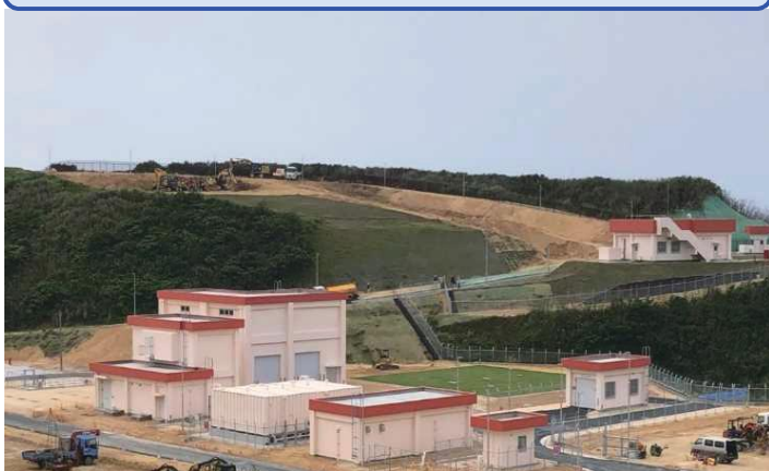
保良訓練場に完成した施設 (警衛所、整備場、浄化槽、給水所、受電所など)
