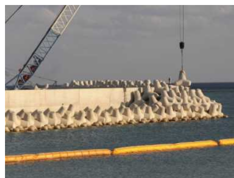
(令和2年11月撮影) K-1護岸 消波ブロック施工状況
