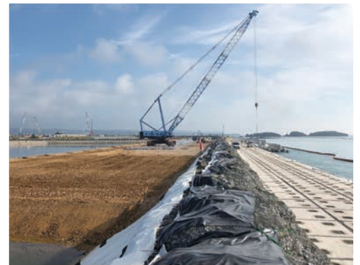
K-4護岸 消波ブロック設置状況 (令和2年2月撮影)
