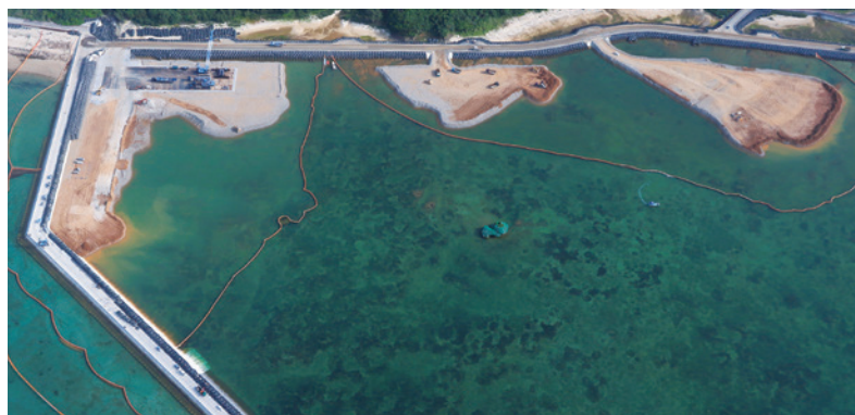
埋立区域② 埋立状況
