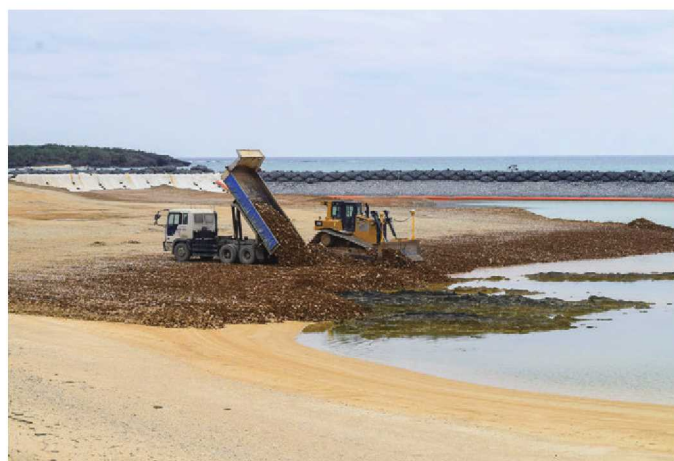
埋立工事施工状況
