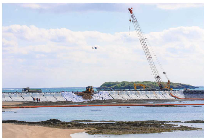
埋立工事着手時
