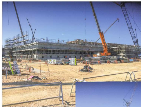
【隊庁舎・工事状況】
