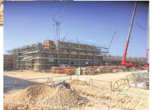
【食堂・福利厚生・工事状況】
